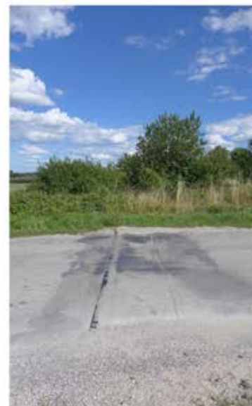
Fragment torowiska JKD na przecięciu z drogą powiatową nr 0022T w Wierzbju.
