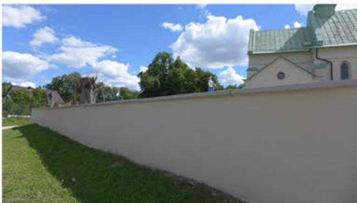
Fragment ogrodzenia - odcinek północno-wschodni od strony drogi asfaltowej.
