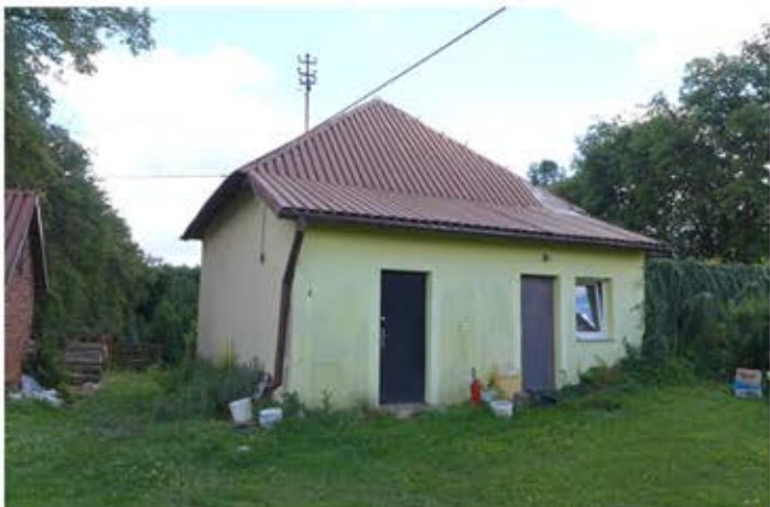
Widok od strony północnej.
