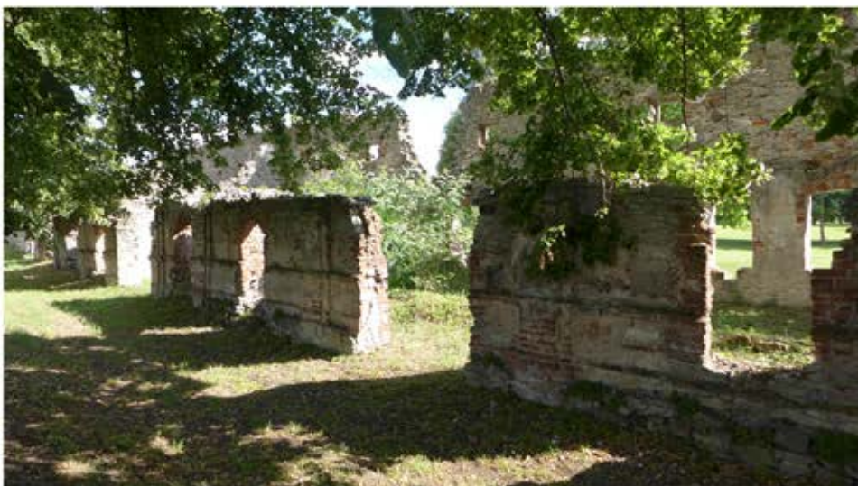
Widok od strony północnej, przy drodze powiatowej nr 0001T (Brody-Maleszowa).
