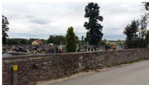
Cmentarz parafialny z ogrodzeniem w zespole kościoła parafialnego. Widok od strony wschodniej, od ul. 13 Stycznia.
