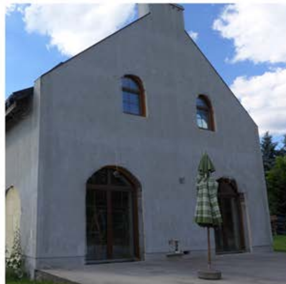
Wschodnia ściana szczytowa, od strony stawu.
