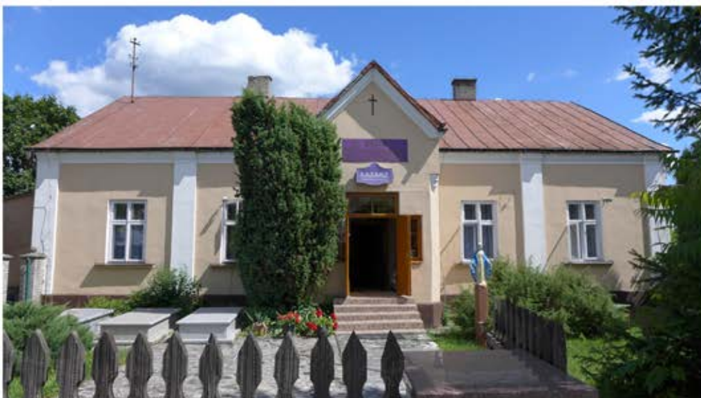
Widok od strony północno-zachodniej, od ul. Kościelnej.
