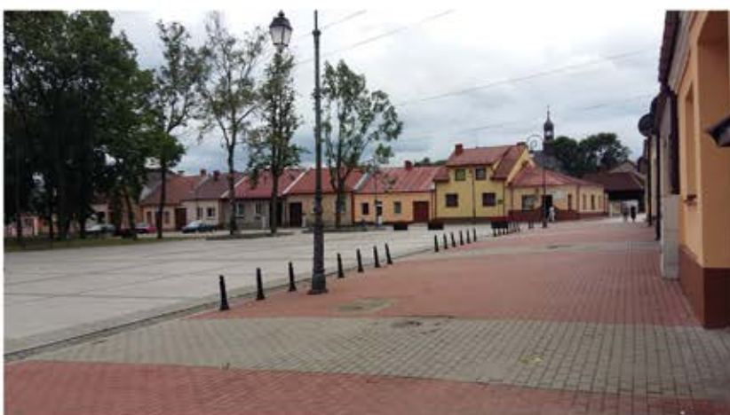
Rynek, południowo-zachodnia pierzeja. Pozostałości najstarszej zabudowy mieszkalnej. W tle góruje wieża kościoła parafialnego św. Małgorzaty. Po prawej skwer obejmujący centralną część płyty rynku.
