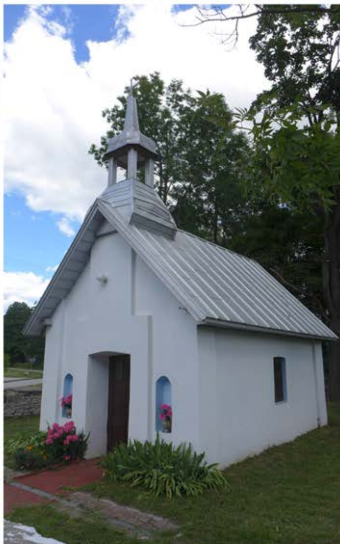
Widok od strony południowej.
