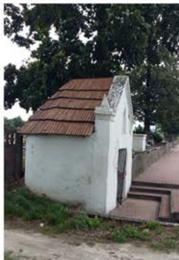
Widok od strony północnej.
