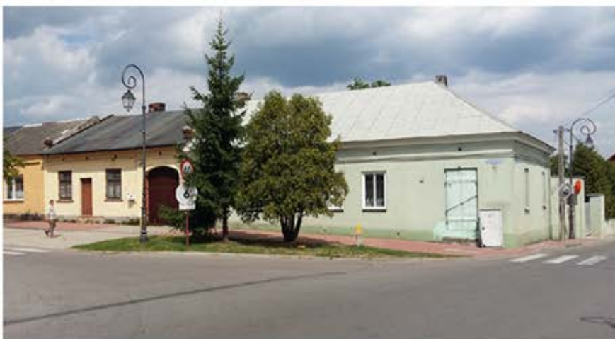
Widok na narożny budynek nr 19, od strony południowo-wschodniej pierzei rynku, z wglądem w wylot ul. Kieleckiej.
