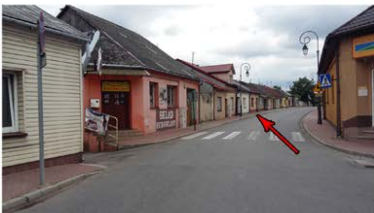
Wgląd w ul. Kościelną od strony rynku. Strzałką oznaczono lokalizację budynku nr 8.
