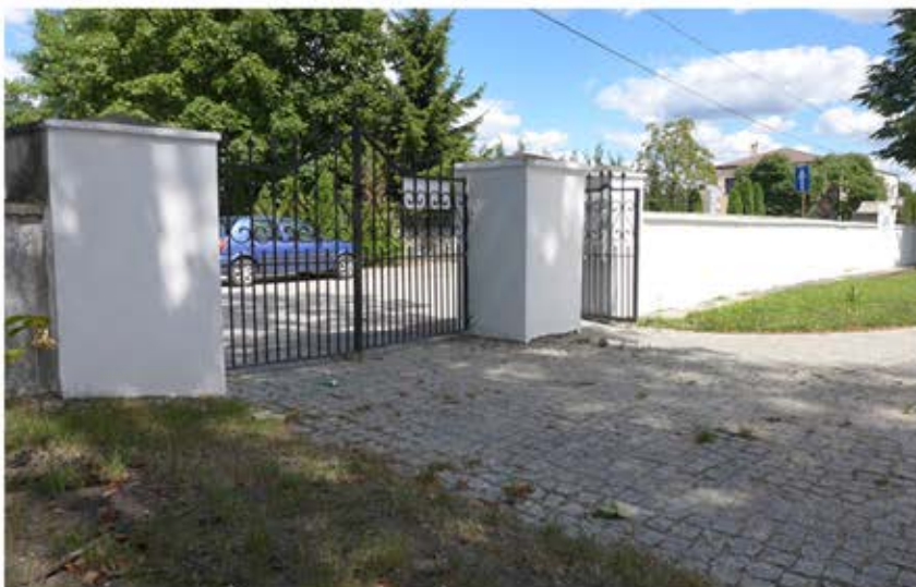
Fragment ogrodzenia z bramą - od strony północno-zachodniej od ul. 13 Stycznia.
