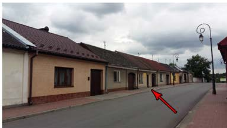
Wgląd w ul. Kościelną od strony rynku. Strzałką oznaczono lokalizację budynku nr 10.
