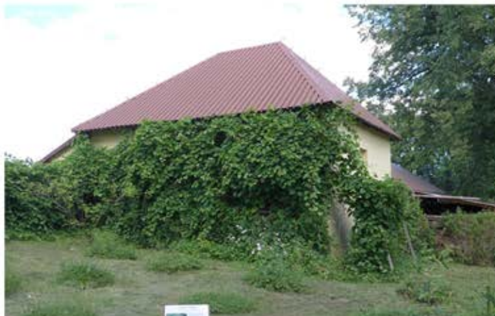
Widok od strony zachodniej.
