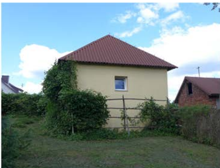
Widok od strony południowej.
