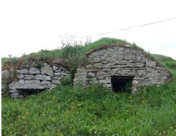
Widok na dwie z zachodnich, skrajnych piwniczek.
